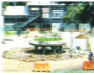
La remodelación registra un avance de 65% /CUARTOSCURO
