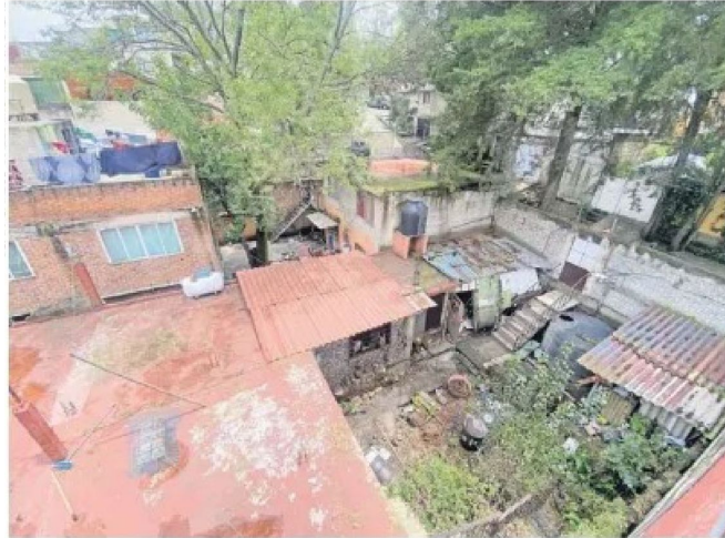
Elisa quedó atrapada en su vivienda, que está por debajo del nivel de la calle; reportes de la SSC indican que murió por ahogamiento.
