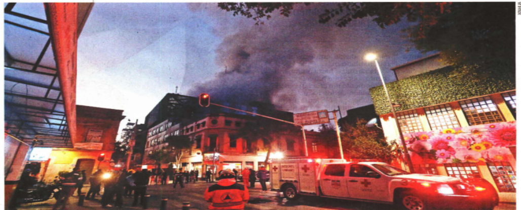
El incendio en las instalaciones de la subestación eléctrica de Buen Tono comenzó a las 5:40 horas del sábado y los cuerpos de emergencia tardaron 11 horas en sofocarlo por completo. Por el momento se desconoce cuándo se puede retomar el servicio en 99 estaciones.
