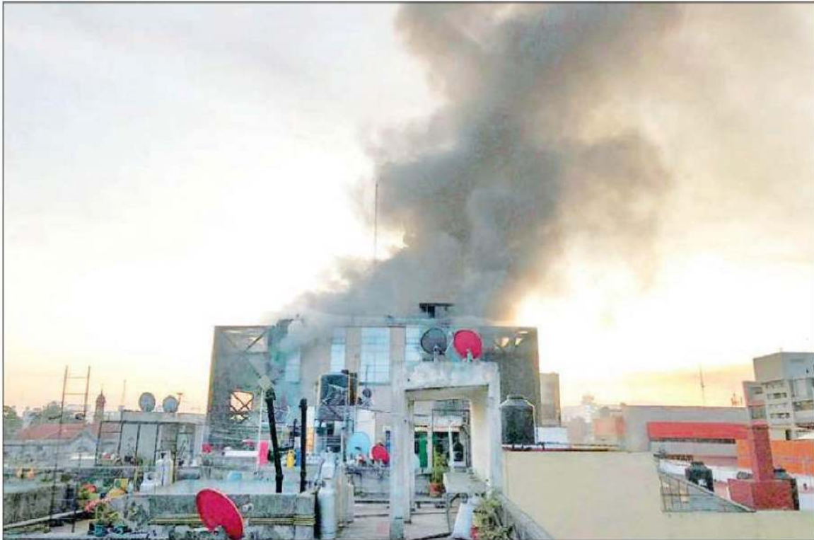
▲ La conflagración registrada ayer en el Puesto Central de Control 1 de la Subestación Eléctrica Delicias del Metro, en la capital del país, dejó una policía fallecida y 30 intoxicados por humo, entre ellos un bombero, así como la suspensión indefinida del servicio en las 99 estaciones de las
