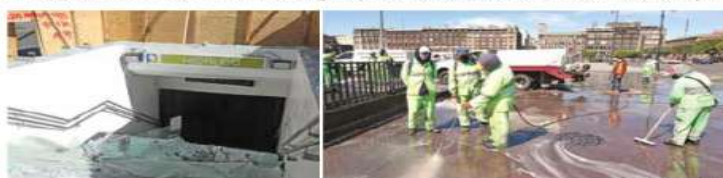
Cuadrillas del gobierno de la ciudad trabajaron en la limpieza y remoción de los daños por el 8M.
