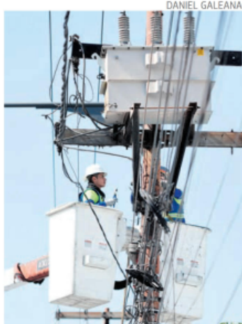
Trabajadores de CFE hacen arreglos
