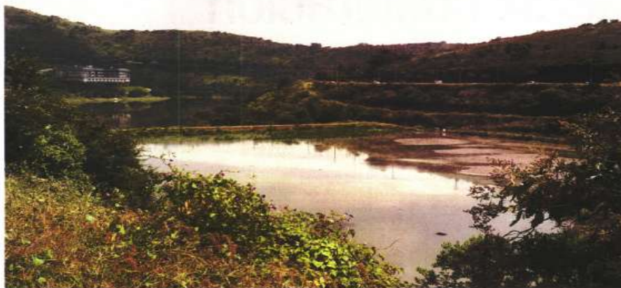
Además de que la presa Madín reporta niveles mayores a su capacidad, ambientalistas denuncian contaminación del agua.
