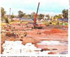
En septiembre se detuvieron las obras en el puente vehicular.
