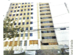
Los trabajos de rehabilitación sólo han concluido en dos niveles.
