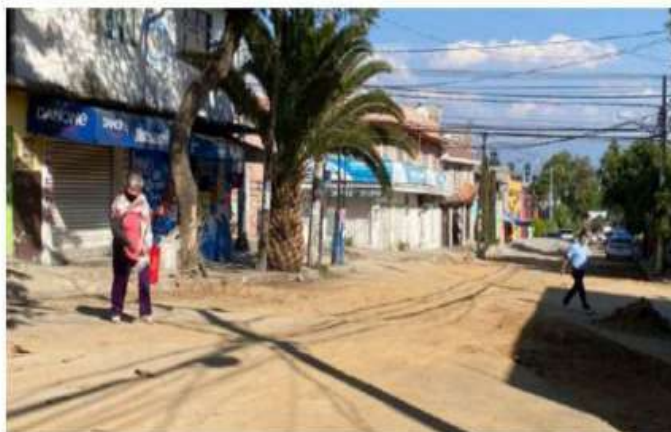
Calles de Peñón de los Baños colonia ubicada en la alcaldía Venustiano Carranza lucen sin postes de luz, sin agua potable en funcionamiento, sin pavimento y hay escombros y excavaciones en la vía pública.
