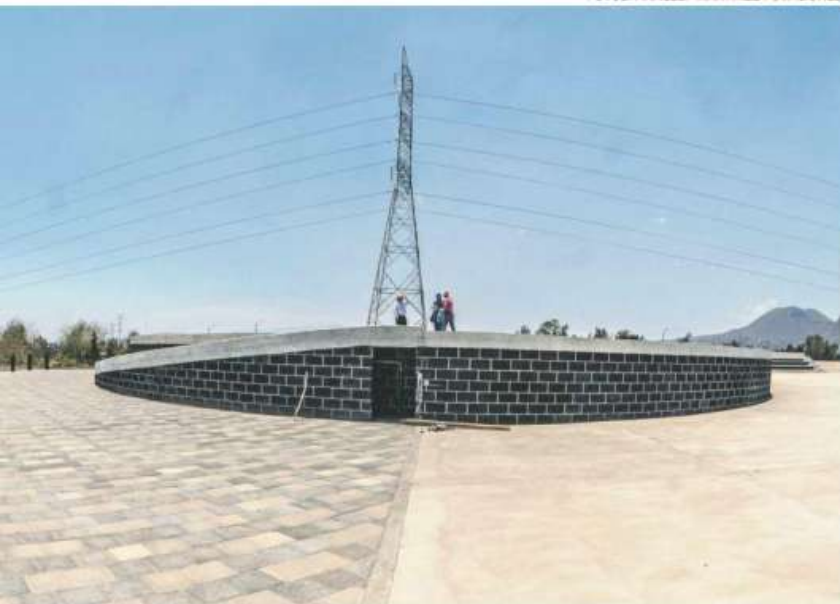
Cerca del bailódromo hay torres de alta tensión lo suficientemente alejadas del sitio
