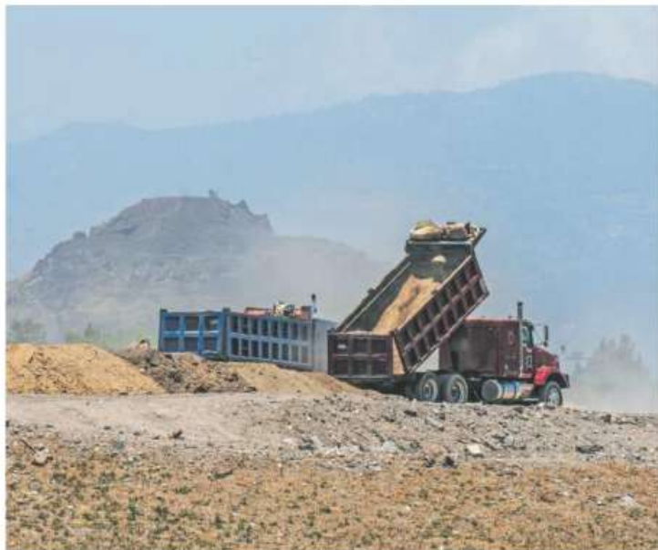
Camiones de volteo acumulan tierra frente al foro para aislar la acústica
