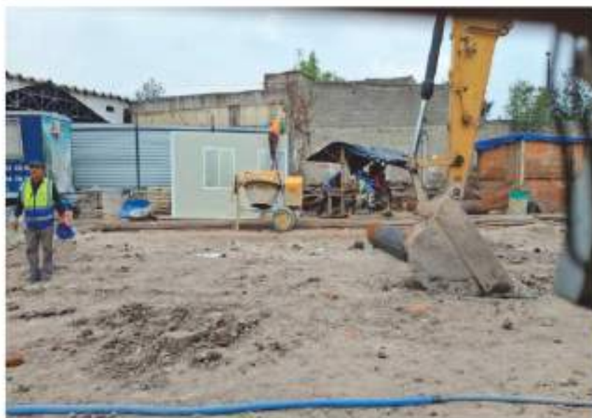
La construcción en avenida Paseo de la Reforma 159, alcaldía Cuauhtémoc.
