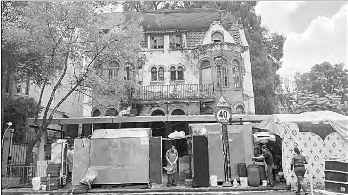
▲ La vieja casona ubicada casi en la esquina de las avenidas Álvaro Obregón e Insurgentes se observa deteriorada y ocupada por el comercio informal. Foto Elba Mónica Bravo
