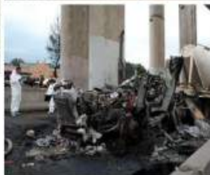
La cabina de la pipa, donde viajaba el conductor, quedó reducida a cenizas.
