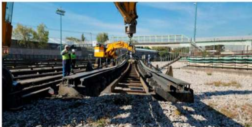
Desmantelamiento de vías en zona de Pantitlán.
