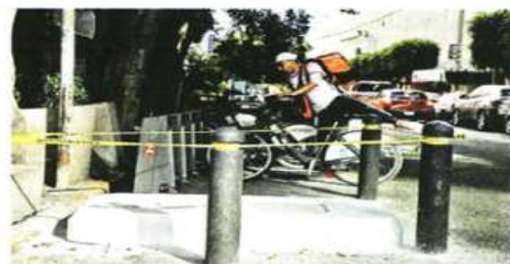
En estaciones de las colonias del Valle, Polanco, Nápoles y Doctores comenzó a ser construida la base.
