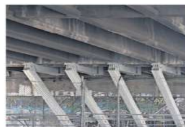
Se han retirado 10 de los 20 puntales colocados de manera preventiva para soportar la carga.
