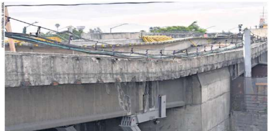
El Metro concluyó el retiro de vías, balasto y elementos electromecánicos del tramo a intervenir en la Línea 9.
