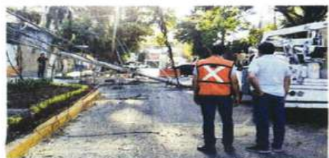
El domingo en Observatorio, un árbol arrasó al desplomarse con cables y quebró un poste de la CFE.
