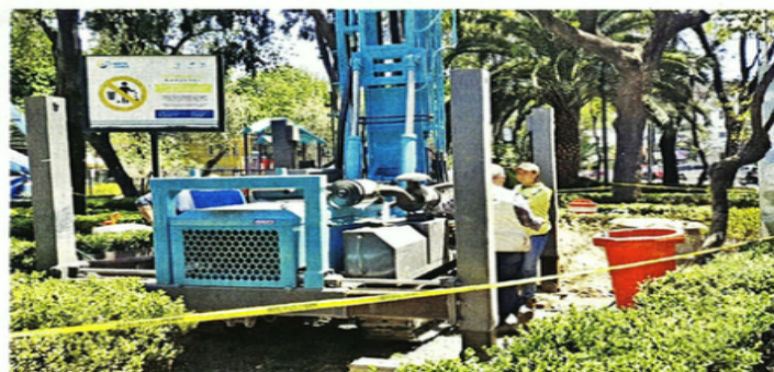
ESTUDIO BAJO LA TIERRA. Una perforadora realizó esta semana maniobras para instalar un sensor a 100 metros de profundidad, en la zona de Mixcoac.
