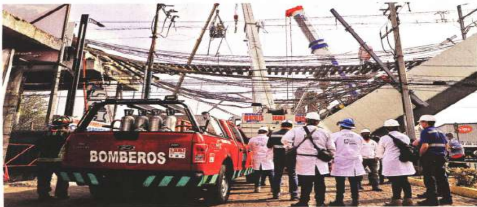
Ayer comenzaron los trabajos de limpieza en la zona del colapso de la Línea 12, en Avenida Tláhuac.
