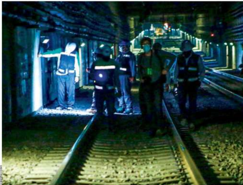
SEGURIDAD. La revisión del túnel de la Línea 12, que consta de 11.5 kilómetros de longitud desde la estación Atlalilco hasta Mixcoac, durará cuatro días.
