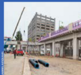
CONSECUENCIA. La madrugada del jueves, fue demolida la pista de patinaje urbano, dentro de las obras de la Calzada Flotante de Tlalpan.
