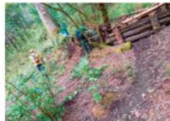
LABORES. Se construyen presas de troncos y ramas, se acomoda material vegetal.
