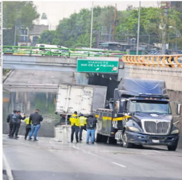
Bajopuentes de Boulevard Puerto Aéreo y Avenida 8 (Izq.) y Eje 4 con Río Churubusco, así como accesos a la TAPO amanecieron anegados por la tormenta del domingo.
