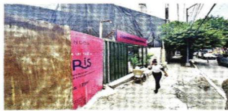
El edificio presenta avance y, pese los daños que provocó, ayer no lucía sellos de suspensión o clausura.
