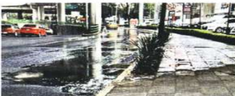
Para evitar el desperdicio sobre Periférico, casi esquina con Campos Eliseos, la válvula fue cerrada.
