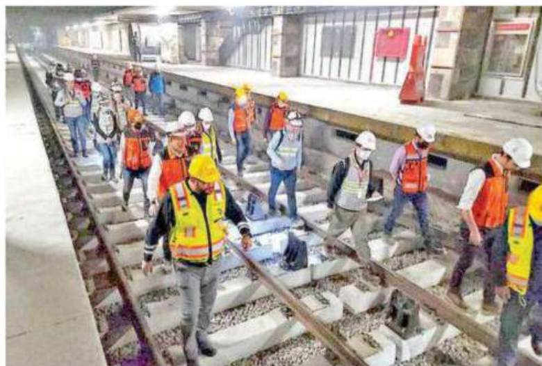
Los funcionarios constataron el tendido del nuevo sistema de vías /CORTESÍA: STC METRO
