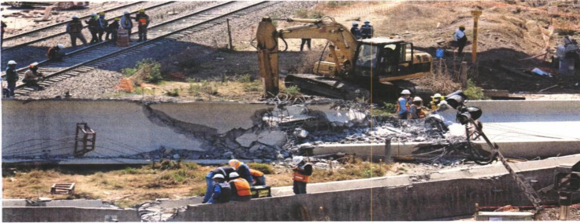
La trabe que forma parte de obras de conexión hacia el AIFA colapsó en los apoyos 5 y 6 de la gaza 290, al momento de ser instalada en el tramo.
