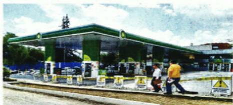
Una gasolinera resultó afectada por las obras en la zona, por lo que tuvo que cerrar.
