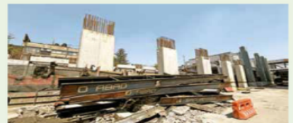
Las cubiertas de la estación fueron desmontadas.
