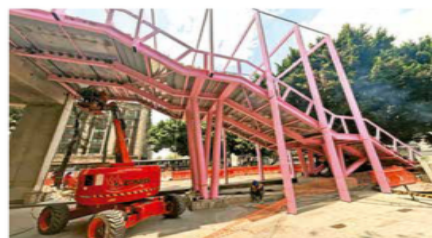
En los 1.5 kilómetros del corredor elevado se observó que las escaleras serán uno de los accesos principales.
