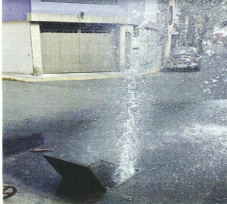
Con el pozo funcionando aumentaron la presión y las fugas. Como ejemplo, la registrada apenas el domingo.
