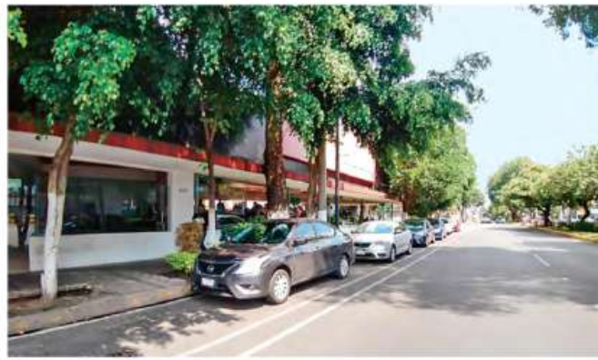
MOVILIDAD. La falta de infraestructura mayor, como bolardos, permite que los automovilistas se estacionen en el carril de uso preferencial para bicis.
