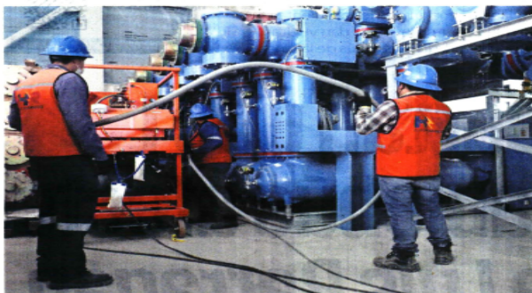
En septiembre finalizará la edificación de la SEAT Buen Tono, que dotará de mayor energía a las líneas 1, 2 y 3; la obra se realiza en conjunto con la CFE.
