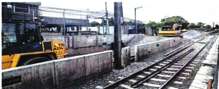
En la Línea 12 se trabaja la rehabilitación del tramo que colapsó el año pasado, además de reforzar el trazo.
