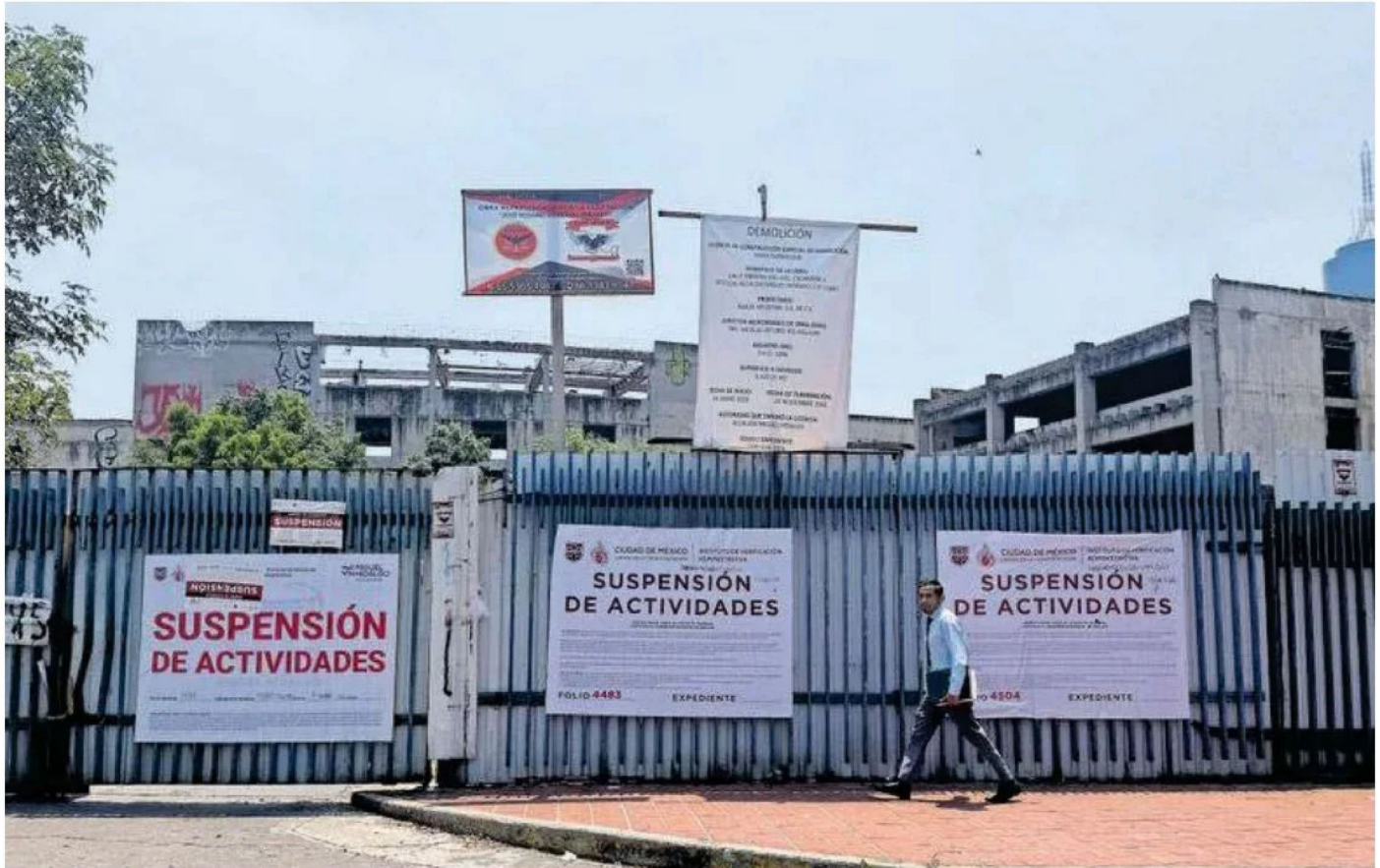
Fachada del predio ubicado en el 145 de la calle Minería, colonia Escandón donde el martes se desplomó un inmueble
