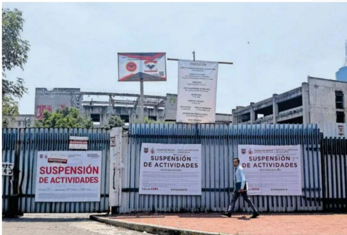
Fachada del predio ubicado en el 145 de la calle Minería, colonia Escandón donde el martes se desplomó un inmueble
