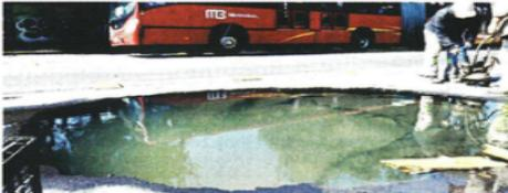
El socavón se encontraba lleno con agua potable de una fuga.
