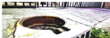
El Gobierno capitalino sumó en los primeros 10 meses de este año 10 mil 912 peticiones de mantenimiento a alcantarillas.
