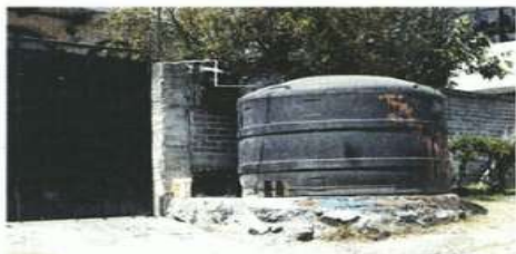
■ Los vecinos de Miguel Hidalgo Tercera Sección señalan que el agua de los contenedores ya es escasa.
