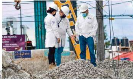
LABOR. En la Zona Cerro, donde el 3 de mayo pasado se desplomó un tramo elevado de la Línea 12, la Fiscalía lleva a cabo peritajes para conocer la causa del accidente.
