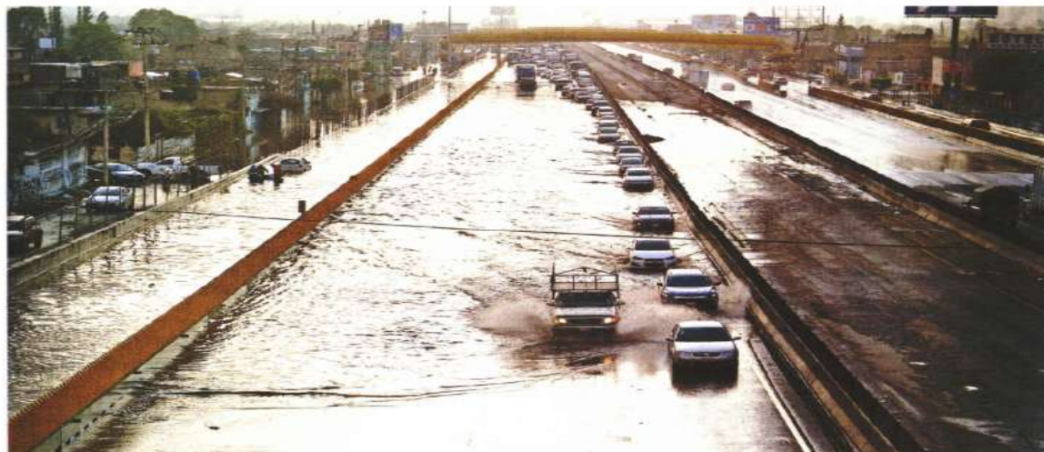
La autopista México-Puebla estuvo cerrada varias horas debido a las inundaciones en unos tramos.
