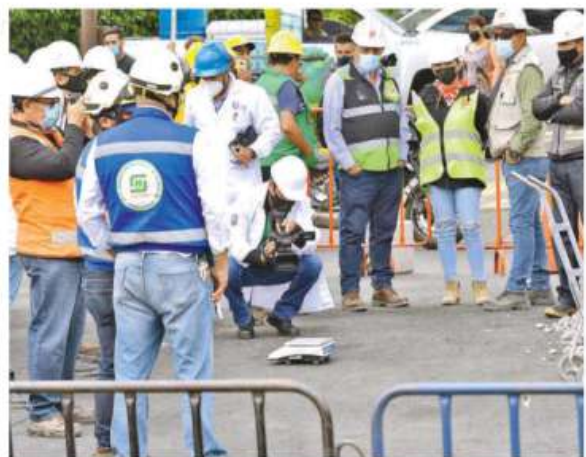
Siguen los trabajos dentro de la denominada zona cero, en avenida Tláhuac /FOTO: DAVID DECLARTE
