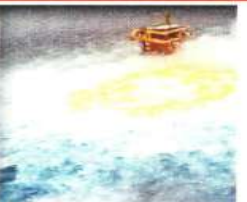
JULIO, 2021. Gasoducto de la plataforma KU-C, en la Sonda de Campeche.
