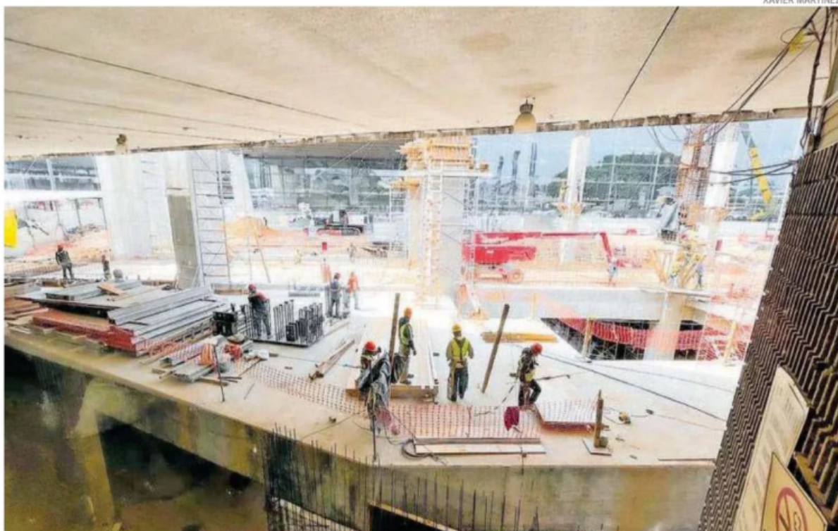
Obras en el Centro de Transferencia Modal (CETRAM) Observatorio en Sur 122 esquina Poniente 85, en la alcaldía Álvaro Obregón
