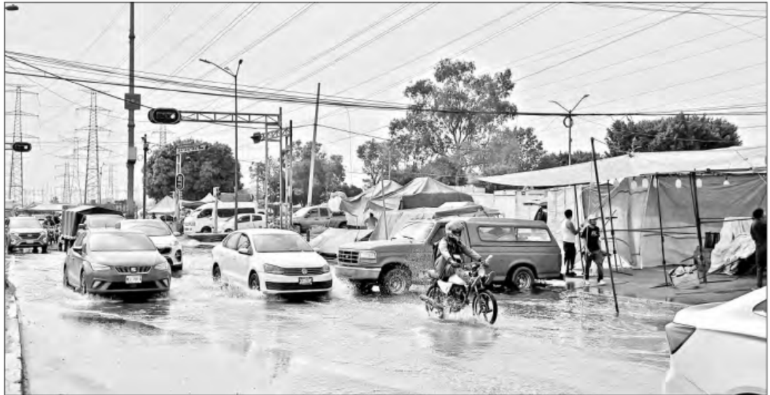
▲ En Iztapalapa, los trabajos de reparación de una megafuga de agua potable en una línea de 20 pulgadas de diámetro ocasionaron rezago vehicular sobre el Eje 6 Sur avenida de Las Torres, a un costado del parque Cuicatlahuac, en la colonia Renovación. Foto Alfredo Domínguez
