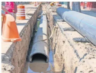
Algunas de las obras, como líneas de presión y colectores, siguen en proceso, informaron.
