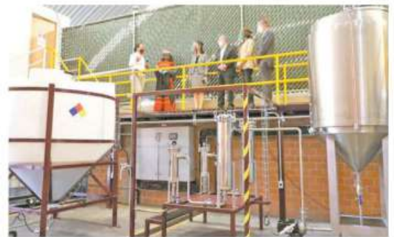
Se inició la construcción de un sistema biodigestión anaerobia para el tratamientos de residuos sólidos orgánicos /FOTO: CORTESÍA GCDMX
