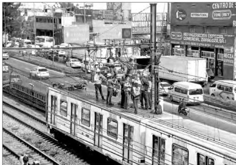
▲ El documento titulado Problemática del taller de mantenimiento sistemático La Paz, detalla que 24 de los 28 trenes de la línea A excedieron el kilometraje, de los cuales, 16 continúan circulando y 12 están fuera de servicio por falta de mantenimiento y refacciones. Foto Alfredo Domínguez
