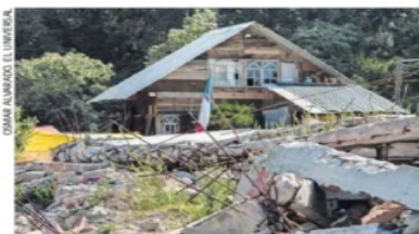
Tras el desalojo realizado por el Gobierno, algunos habitantes construyeron casas de madera.
