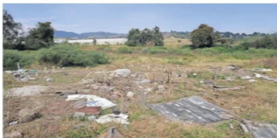
En la zona de suelo de conservación de Tlalpan conviven rastros de viviendas que fueron derrumbadas y otras que se mantienen en pie.
