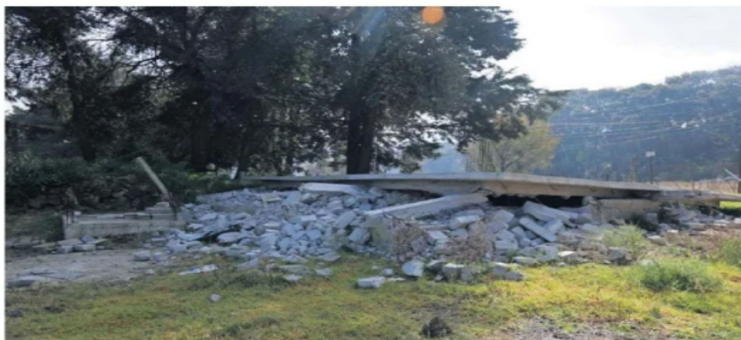
En La Pedrera al menos cinco casas fueron derrumbadas y están relacionadas con ventas irregulares.
