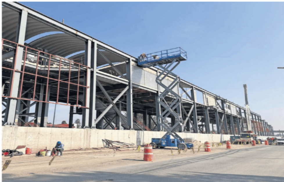
Actualmente falta como más de 30% para concluir la obra del Tren Suburbano al AIFA, señaló un funcionario de Ferrocarriles Suburbanos.
