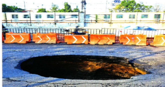
El socavón en la alcaldía Iztapalapa se abrió la tarde del 13 de agosto en los carriles centrales de la calzada, tiene 4 metros de largo, 2.5 de ancho y 4.5 de profundidad sobre la tubería de drenaje.
