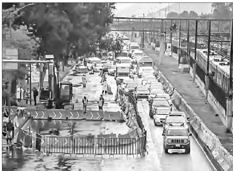
◀ Cientos de automovilistas resultaron afectados debido al par de socavones que se originaron en la calzada Ignacio Zaragoza. Foto Víctor Camacho
