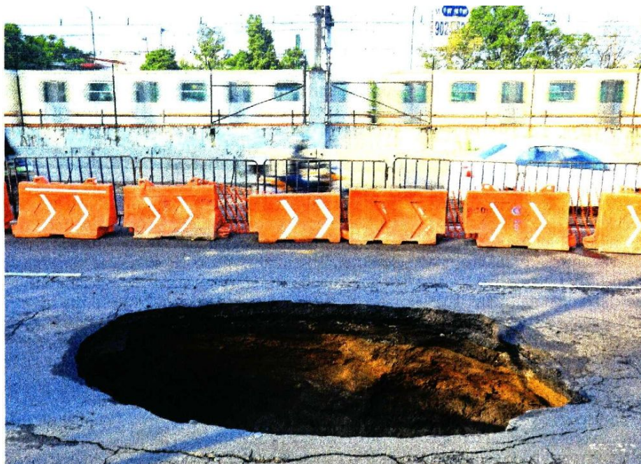
El socavón en la alcaldía Iztapalapa se abrió la tarde del 13 de agosto en los carriles centrales de la calzada, tiene 4 metros de largo, 2.5 de ancho y 4.5 de profundidad sobre la tubería de drenaje.
