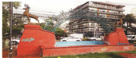
La estructura que sostiene el arco luce grafitis, en tanto que la fuente carece de agua.
