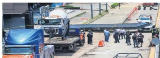
La estructura metálica cayó sobre la camioneta Honda blanca.
