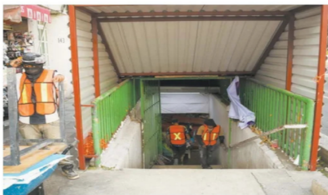
En el paso a desnivel de San Antonio Abad y Gutiérrez Nájera continúan las obras.
