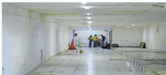
Algunos pasos a desnivel ya se encuentran limpios y con iluminación, aunque aun no se observan trabajos de rehabilitación.
