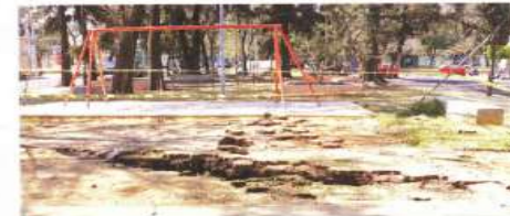
El terreno quedó quebrado cerca del parque en remodelación.
