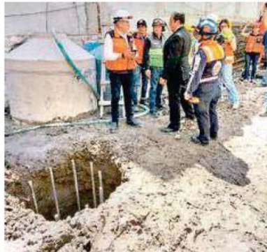
LÍNEA 12 DEL METRO
