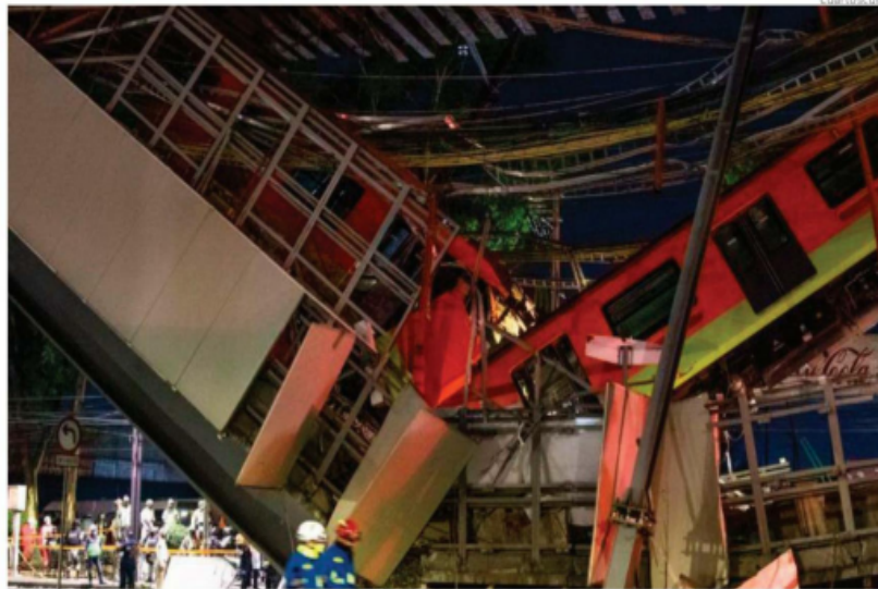
Dos vagones del metro quedaron colgando del tramo elevado de la Línea 12, a la altura de la estación Olivos, en mayo de 2021.
