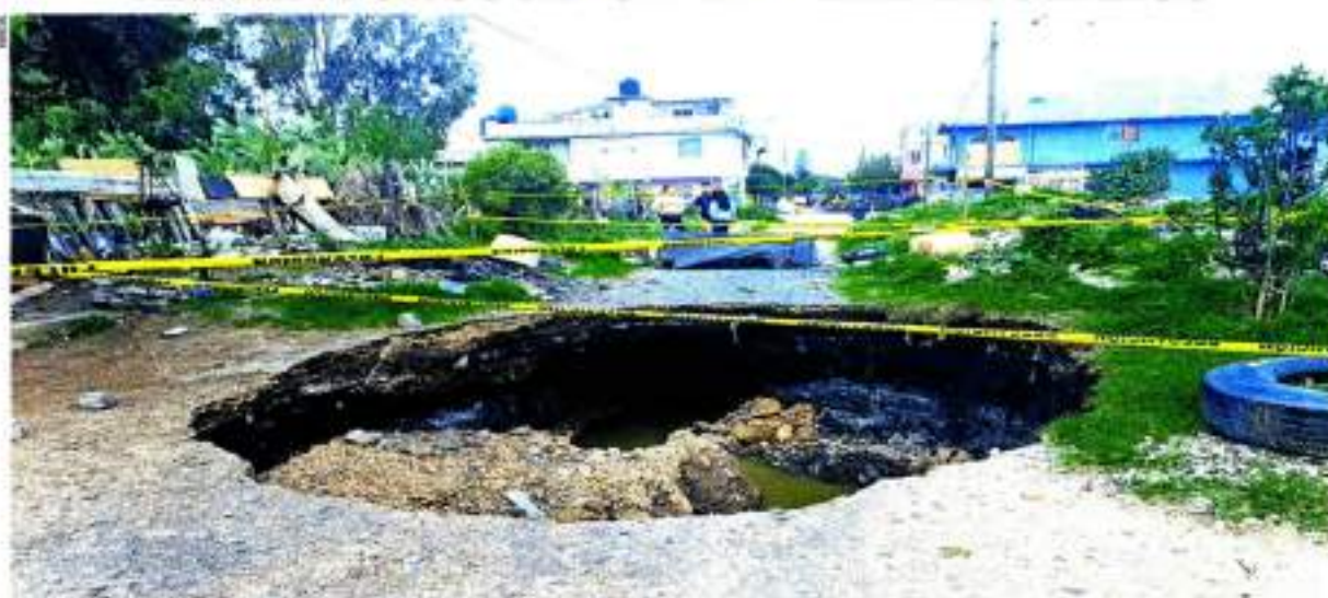
Valle de Chalco, Méx.— Un socavón de casi 10 metros de longitud por cuatro metros de ancho y dos de profundidad se formó en los últimos días en la colonia San Isidro, debido a las lluvias que reblandecieron el suelo y tienen en alerta a los vecinos de las calles Norte 15 y Oriente 17.
