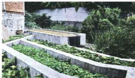
MITIGACIÓN. Las obras que lleva a cabo la Sedema prevén la construcción de un humedal, que limpie las aguas negras.
