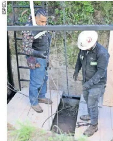
La recuperación de restos se realiza con poleas y andamios, detallaron.
