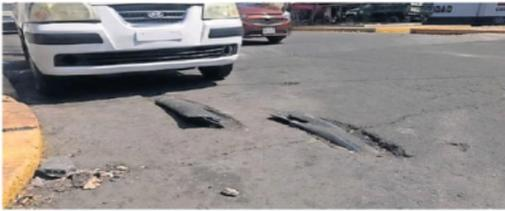
En las calles hay tubos de polietileno sueltos, que sobresalen de la carpeta asfáltica y no están debidamente conectados a la red hidráulica.
