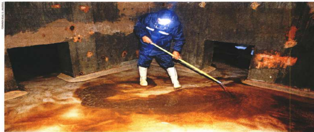
Para lavar la cisterna, el trabajador utilizó un detergente biodegradable para descomponer las grasas acumuladas y 8% de hipoclorito de sodio para potabilizar el agua.
